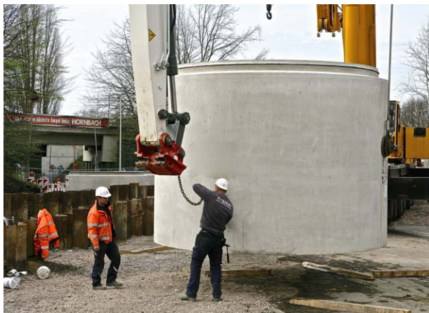
Die überdimensionalen Stahlbetonrohre konnten bei einer Durchfahrthöhe von oft lediglich 4 m nur senkrecht zur Baustelle transportiert werden
