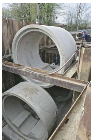
Das zentimetergenaue Absenken und Montieren erfordert passgenaue Rohre
