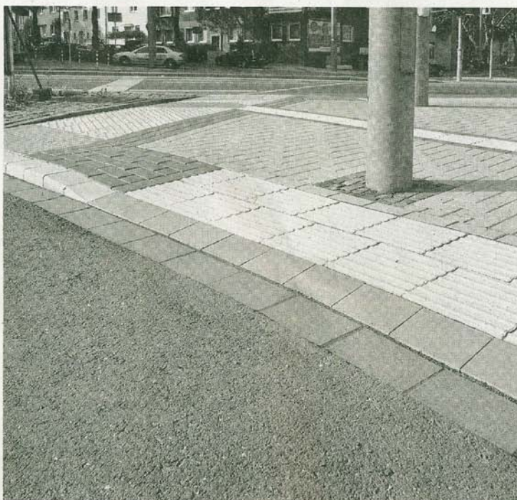
Das Sicherheits- und Leitsystem von Berding Beton umfasst sowohl taktile Bodenindikatoren mit unterschiedlichen Ausprägungen, Blockstufen mit Stufenkantenmarkierungen, als auch das neu entwickelte Querungsstein-System. Foto: Berding Beton
