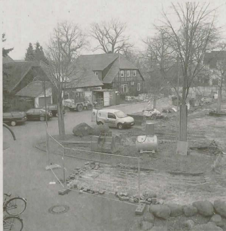
Zu Beginn der Sanierungsarbeiten war kaum vorstellbar, wie offen und freundlich der Rathausplatz in Hermannsburg nach der Baumaßnahme wirken wird. Foto: Gemeinde Hermannsburg
