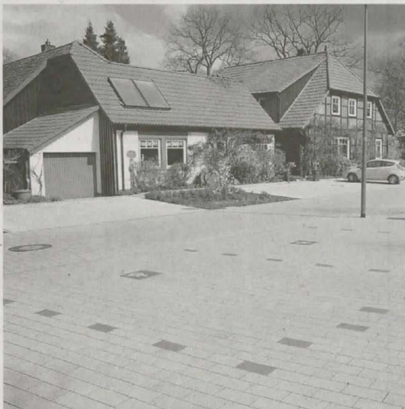
Nach der Sanierung: Im Zuge der Erneuerungsmaßnahmen in Hermannsburg wurde deutlich mehr sich nun die höhengleichen Flächen teilen.
