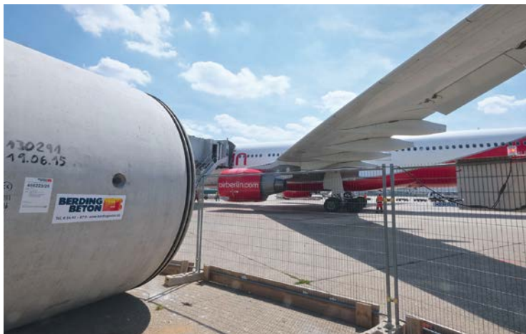
Hochleistungs-Stahlbetonrohre mit einem Außendurchmesser von 3400 mm wurden Rohr für Rohr in Sondertransporten und genau festgelegten Zeitkorridoren auf die Baustelleneinrichtungsfläche geliefert.
