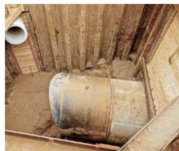
Vortriebsmaschine in der Zielbaugrube. Im Bild oben: Einfahrtöffnung für einen Vortrieb DN 1000 zum Einbau von Kabelschutzrohren mit einem Höhenversatz von 3,40 m oberhalb der Hauptvortriebssohle
