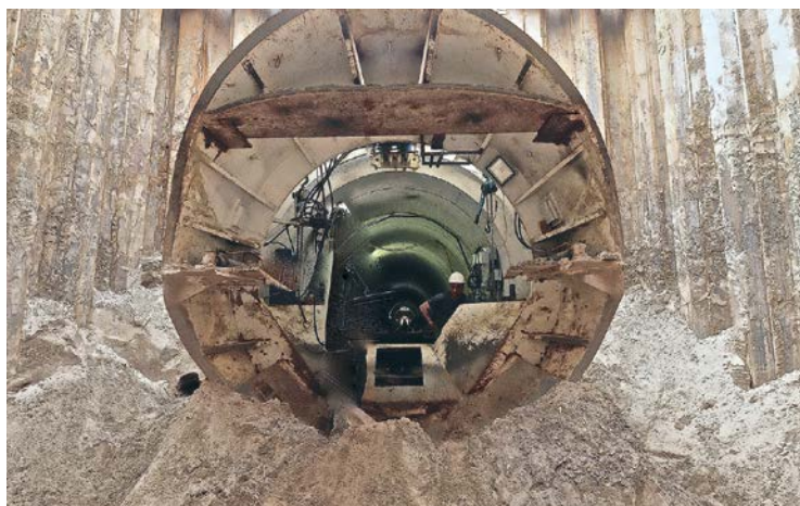
Blick aus der Vortriebsmaschine in den Infrastrukturkanal
