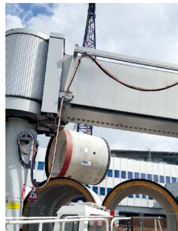
Auch eine logistische Herausforderung: das „Einfädeln“ eines 22 Tonnen schweren Vortriebsrohres in die Baugrube
