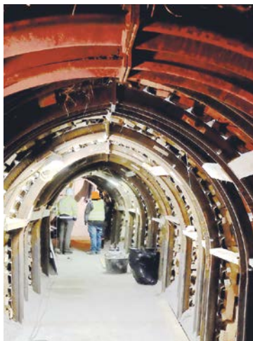
Blick in den Stollen mit biegesteifem Stahlverzug
