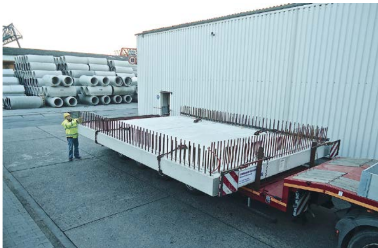
Anlieferung eines Schachtelements mit im Betonwerk integrierten Einbauteilen
