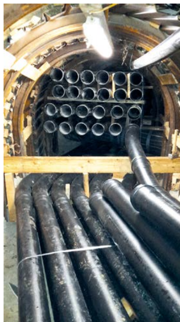
Anbindung der Leerrohre unterhalb der Bodenplatte im Terminal C
