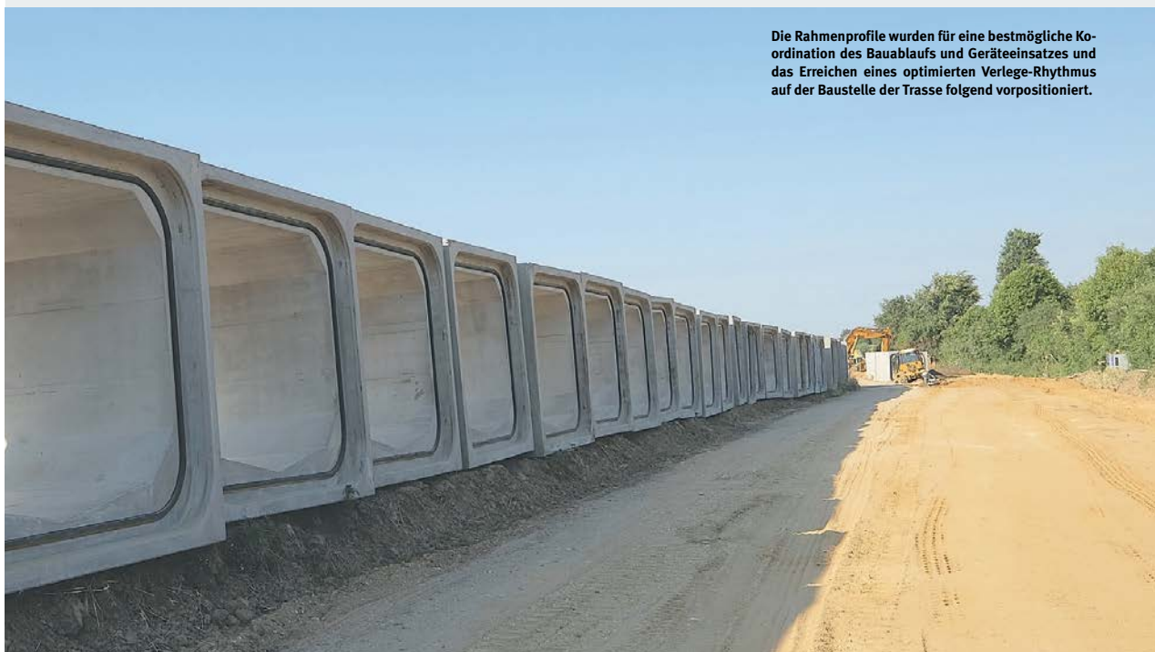
160 Schwertransporte: Streckenweise wurde bei der Beförderung der über 3 Meter langen Fertigteile auf der genehmigungspflichtigen Route vom Herstellerwerk zur Baustelle behördlich der Einsatz von Begleitfahrzeugen (BF 2) vorgeschrieben.
