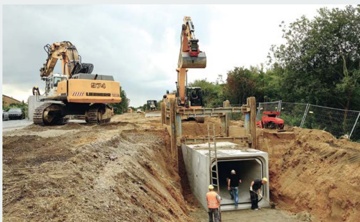
Koordinierter Geräteeinsatz auf der Baustelle: Erdaushub, Transport der Stahlbetonrahmen, Montage, Verfüllung, Bodenverdichtung mit speziellem Gerät, besonders für den seitlichen Zwickelraum neben den Fertigteilen.
