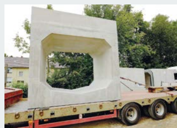
Das Sammler-Einlaufelement wurde im Fertigteilwerk direkt mit einer auf der Deckenfläche betonierten Flügelwand hergestellt.
