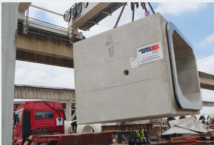
Bei der Herstellung der Stahlbeton-Rahmenprofile ist eine auf das Profil und den Einsatzzweck modifizierte Betonrezeptur zum Einsatz gekommen, die die Anforderungen des Bauherrn, der NEW AG, sicher erfüllt hat.
