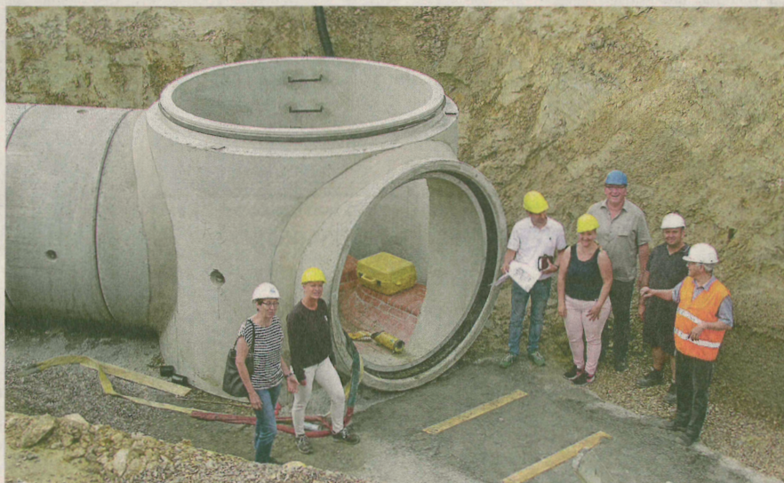
Projektleiter Uwe Koch (rechts) erläuterte den Stand der Bauarbeiten für den großen Stauraumkanal im Evesser Baugebiet „Vor den Flachsrotten“. Über den Stand der Arbeiten informierte sich auch Evessens Bürgermeisterin Dunja Kreiser (Zweite von links).
