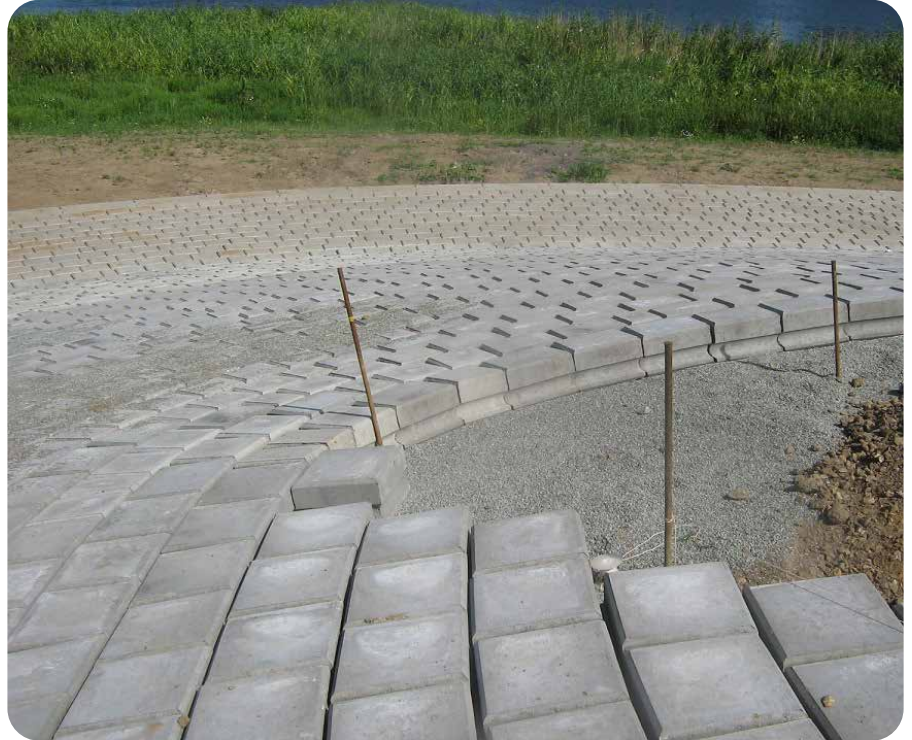
Mit Verkalit®-Steinen lassen sich ohne Sondersteine auch Kurven realisieren, Hoopte ▲
