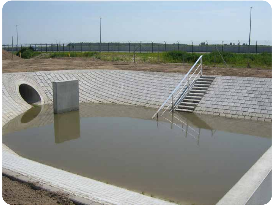
Regenrückhaltebecken Selchow mit systemintegrierter Treppe und Überlauf ▲
