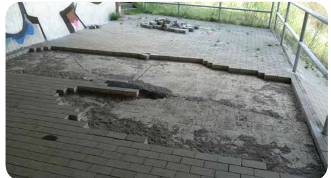
Nicht befestigter linker Böschungsbereich bereits ausgekollt ▲
