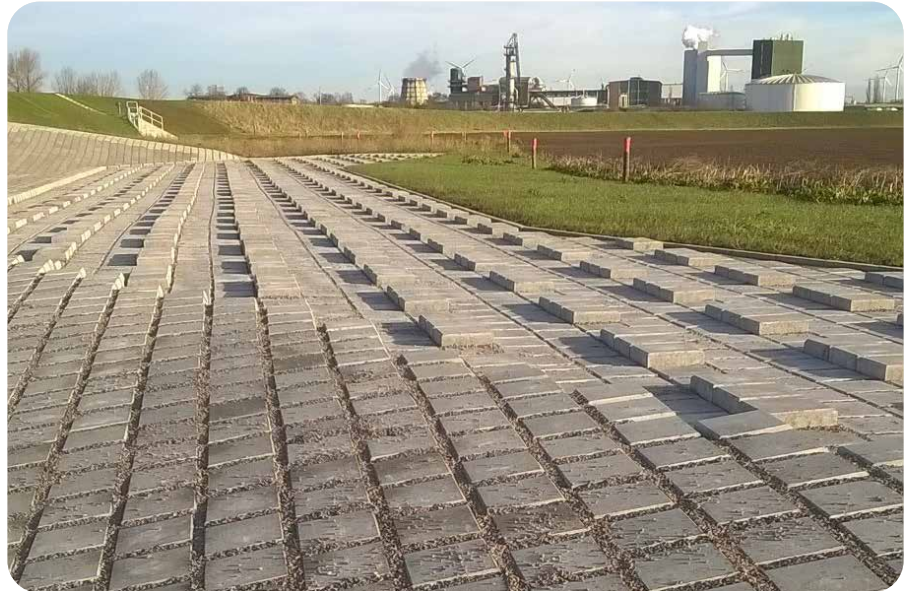
Überströmbauwerk, Mühberg an der Elbe ▲
