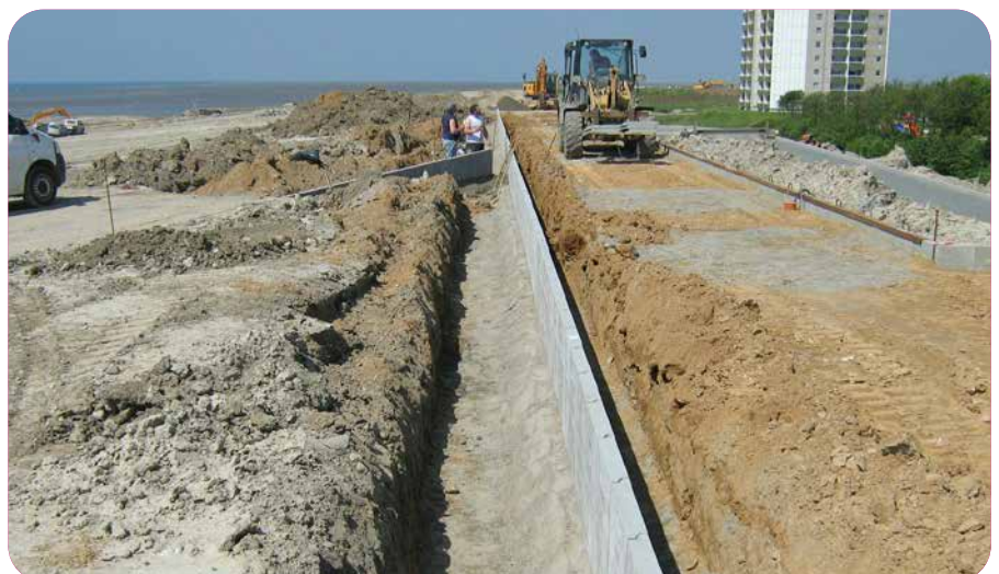
Verkalit®-Deichabschlusssteine als Seitenbegrenzung für einen Promenadenweg ▲
