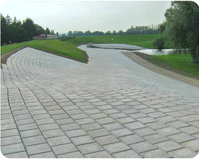
Over, Deichbefestigung, Verkalit®-Stein, 13.000 m 2 ▲
