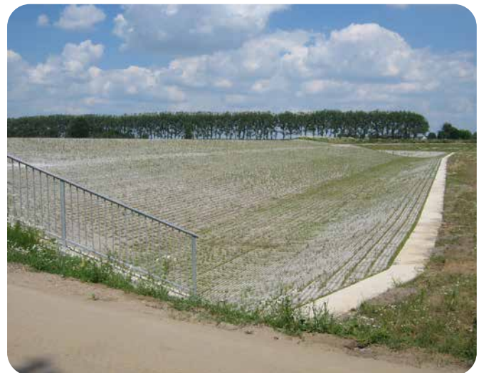
Oppitzsch, Überströmbauwerk, Verkalit®-Öko, 4.500 m 2 ▲
