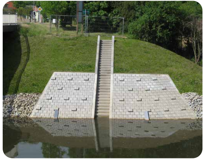
Beidseitige Pegelmessanlage Alte Oder, Verkalit®-Stein mit Störsteinen, 200 m 2 , Wrietzen ▲
