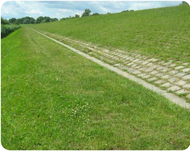
Begrüntes Verkalit®-Deckwerk. Hamburg-Kreetsand ▲
