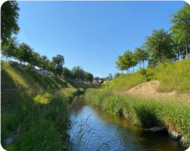
Uferbefestigung Ver. Weißeritz, Verkalit®-Steine, 1.900 m 2 , Dresden ▲
