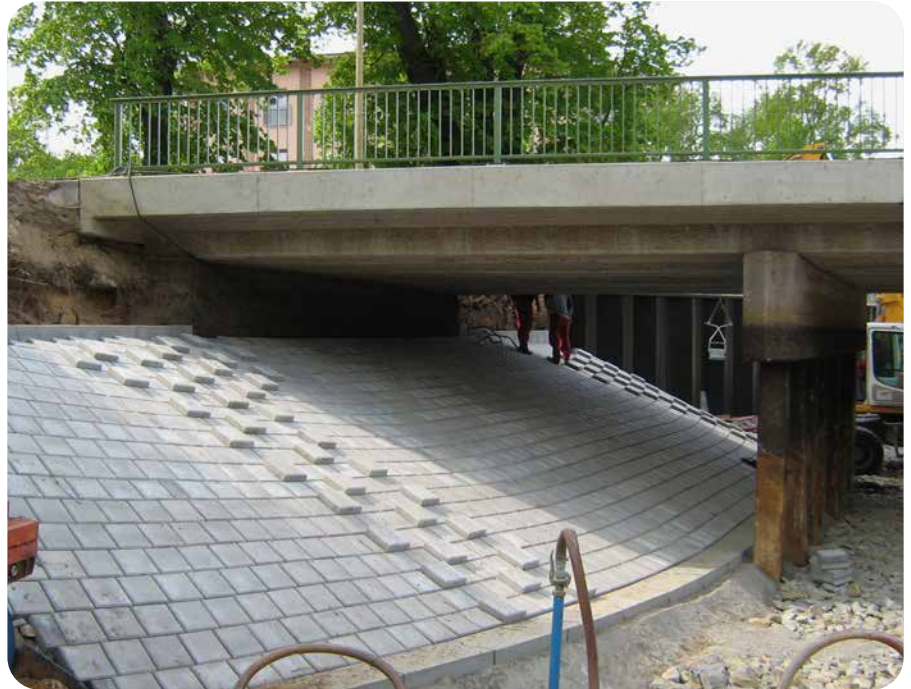
Neuhausen Spreebrücke mit Störsteinen ▲
