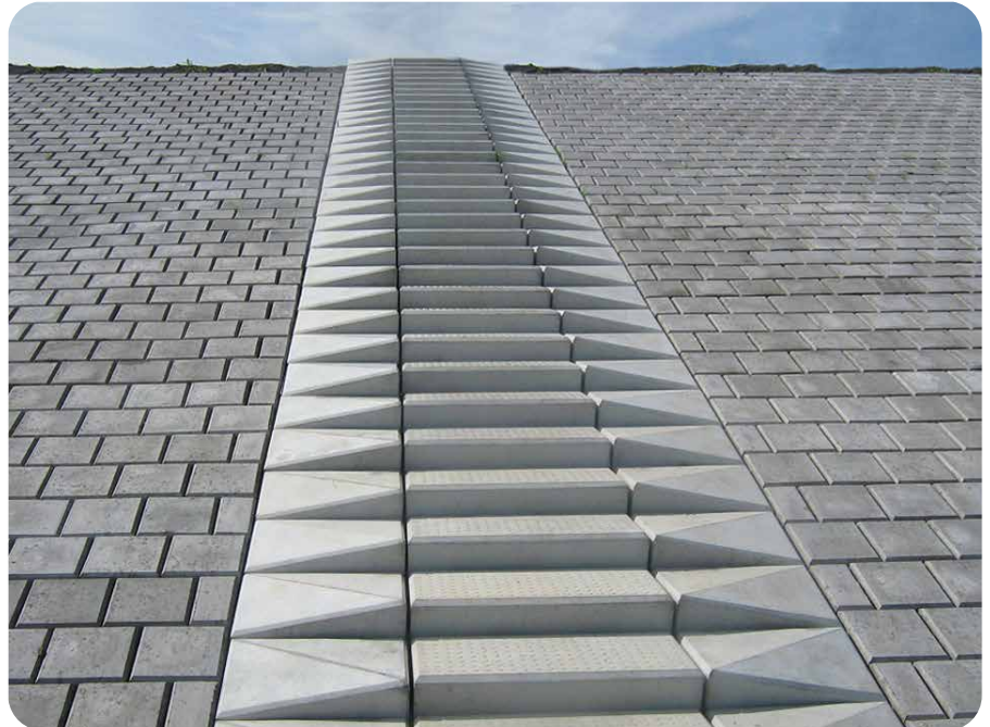
Einfache Integration von Verkalit®-Treppenstufen ins Deckwerksystem ▲
