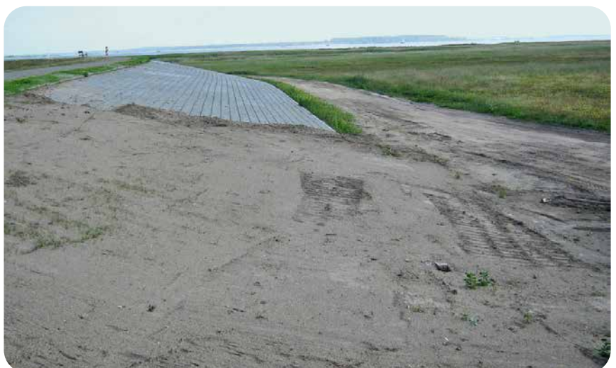
Verkalit®-Deckwerk wird mit Boden abgedeckt ▲
