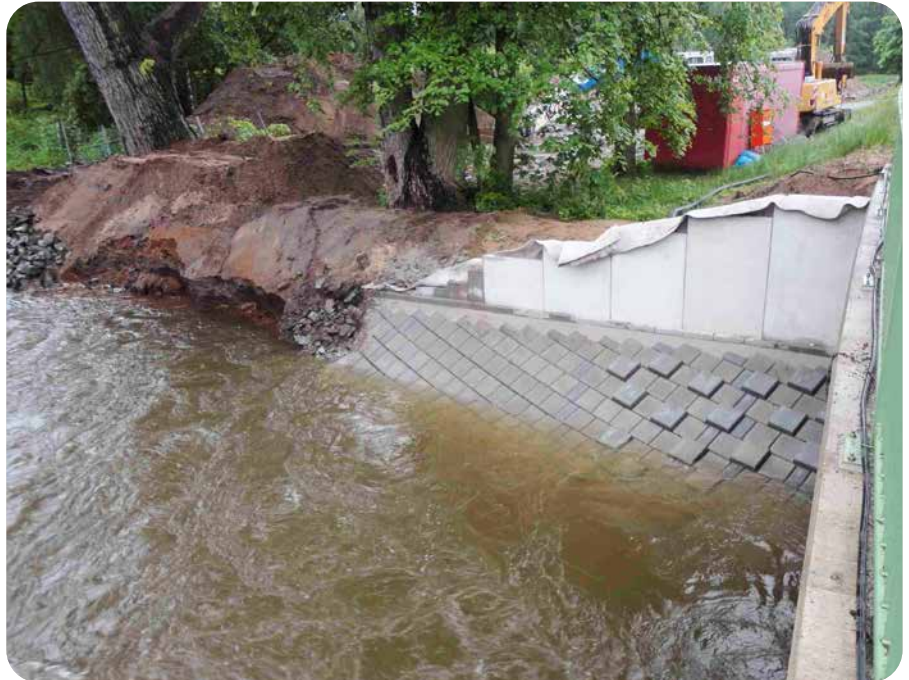
Nicht befestigter linker Böschungsbereich bereits ausgekollt ▲
