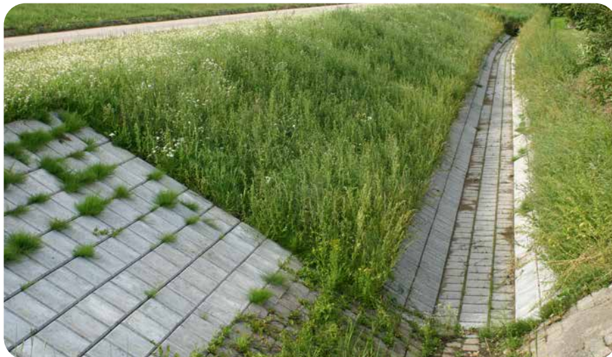
Sohlsicherung zum Auffangen von Sicker- und Quellwasser ▲
