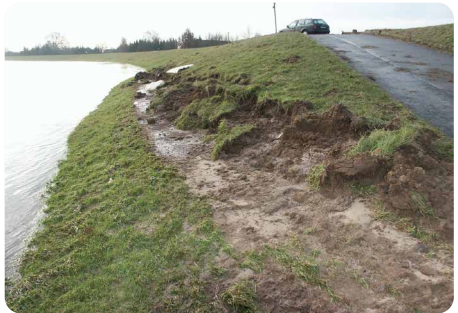
Eisschollen schlitten ungeschützte Deiche regelrecht auf ▶
