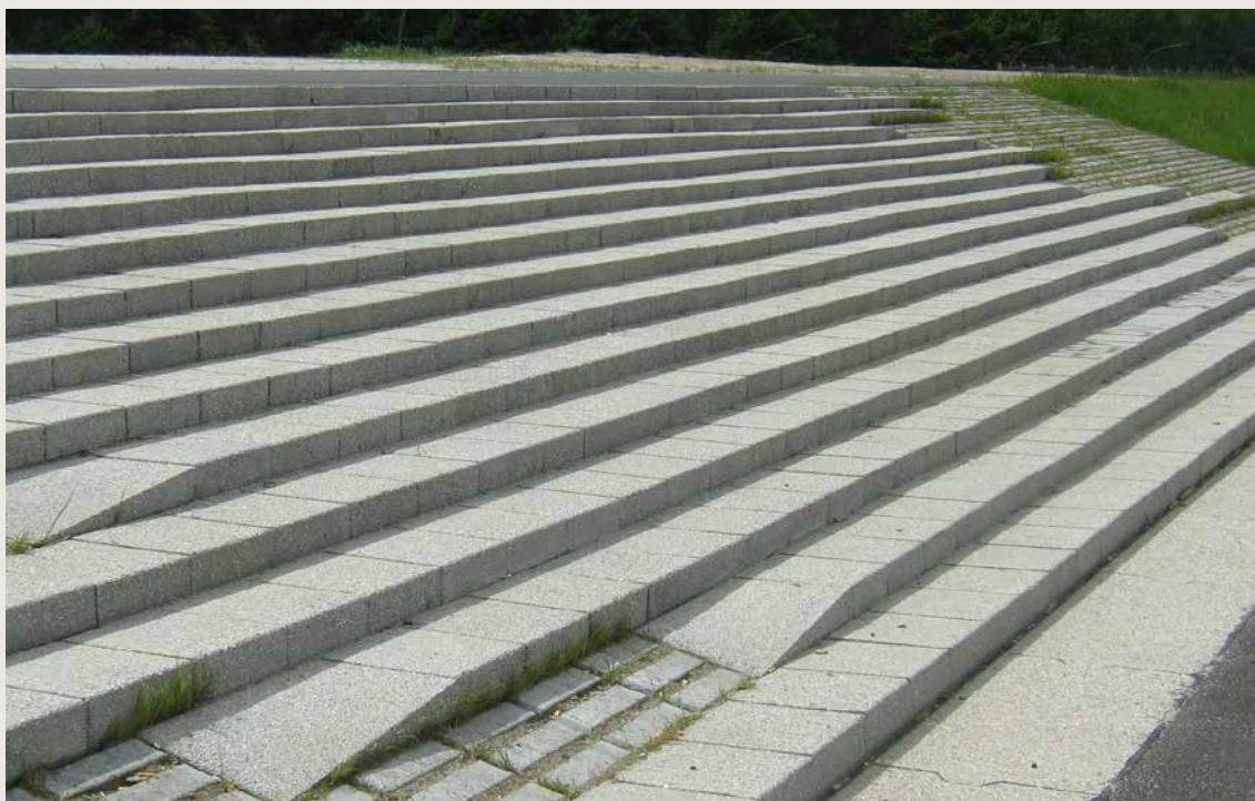
Verkalit ® -Treppensteine mit Verkalit ® -Treppenübergangstein (Sonderausführung) | Klütjenfelder Hauptdeich/Hamburg
