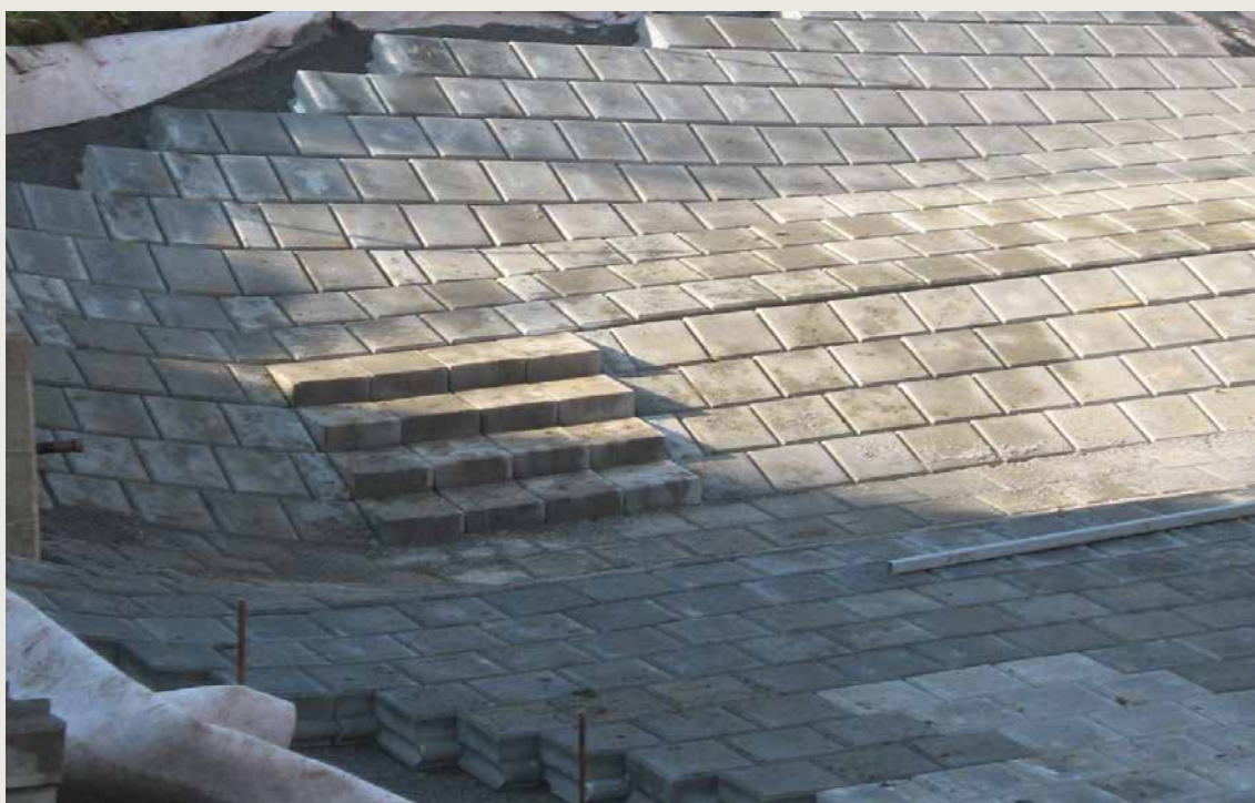
Regenrückhaltebecken mit systemintegrierter Treppe | Berlin Pablo-Picasso-Straße
