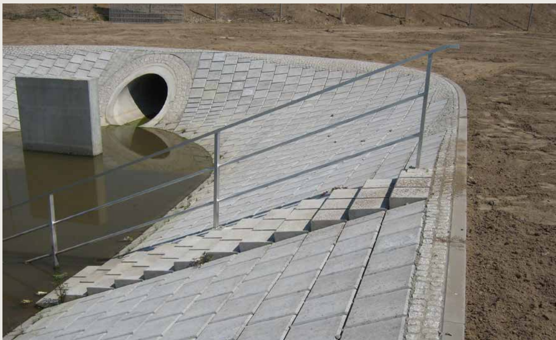
Regenrückhaltebecken mit systemintegrierter Treppe (Neigung 1 : 2) und Überlauf | Messe Berlin-Schönefeld/Selchow Die Befestigung von Geländern auf dem Verkalit ® richtet sich nach der ETA, Anhang 2, Tabelle1.
