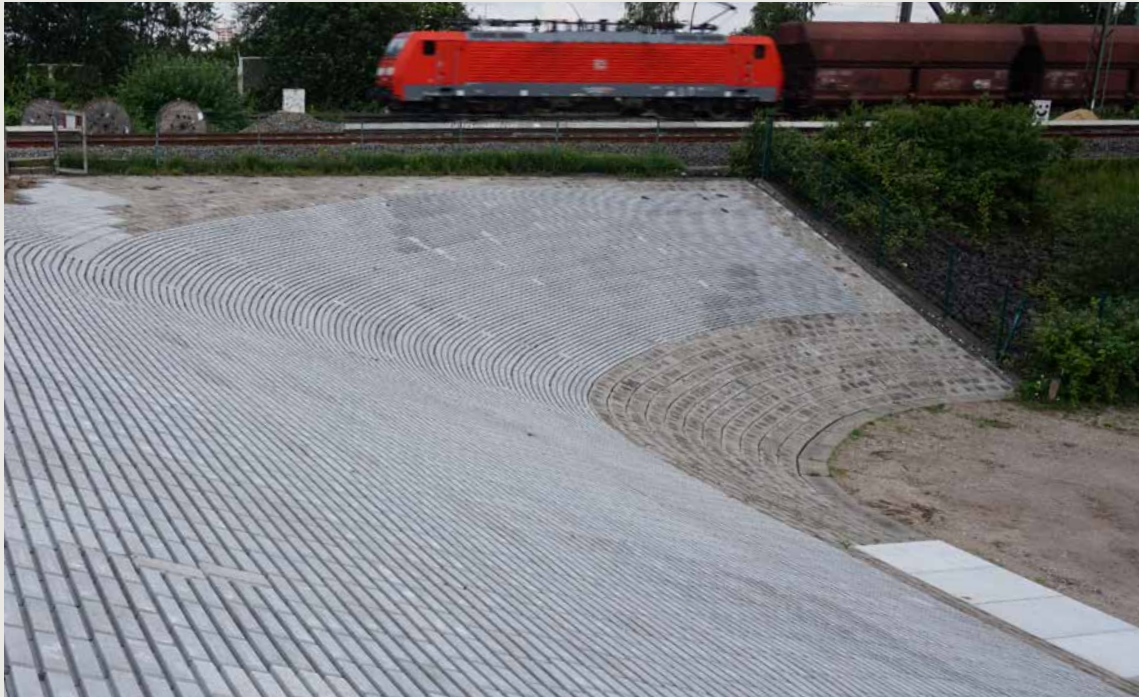
Verkalit®-Öko | Sicherung von Bahndämmen
