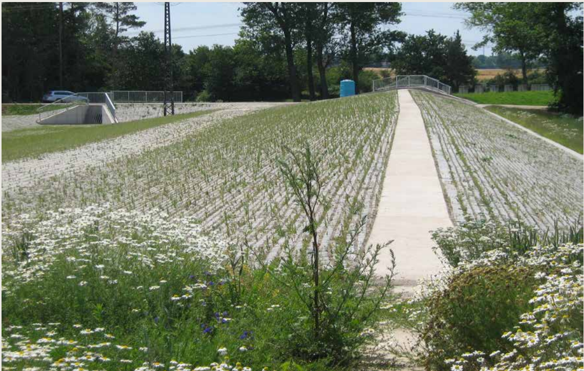
Verkalit®-Öko | Überströmbauwerk Oppitsch
