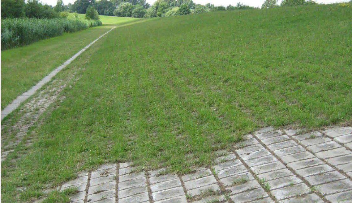
Verkalit ® -Öko-Stein | Begrünung vor Ausbau abgeschält
