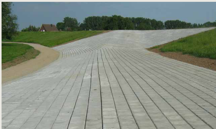
Verkalit ® -Stein | befahrbare Rampe
