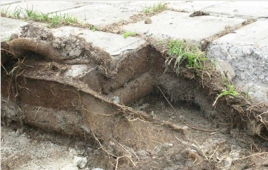
Verkalit ® -Stein | Hamburg Kreesand Hier erkennt man die tiefe Verwurzelung. Optimaler Erosionsschutz am Deich.
