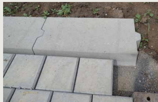
Verkalit ® -Stein | Anschluss an den Holm
