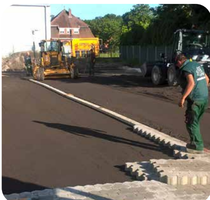
Verlegen von Pflastersteinen auf ECOPREC®-COLD
