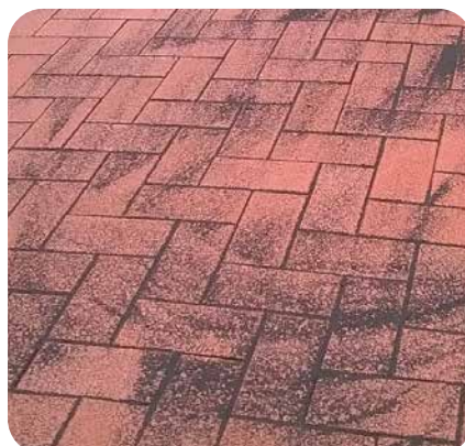
Zur Fugenfüllung kommt ebenfalls das ECOPREC®-Material zum Einsatz
