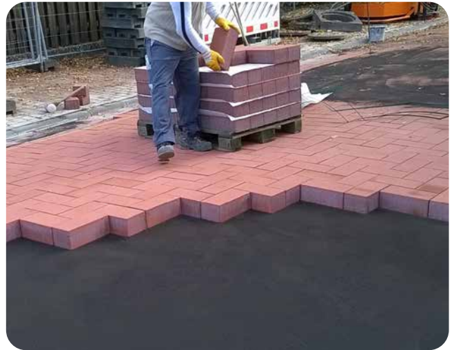
Die Pflastersteine können maschinell oder von Hand auf der neuen Bettungsschicht verlegt werden
