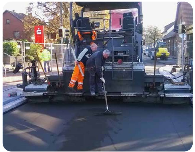
Einbau der ECOPREC ®-Bettungsschicht auf ungebundener Tragschicht
