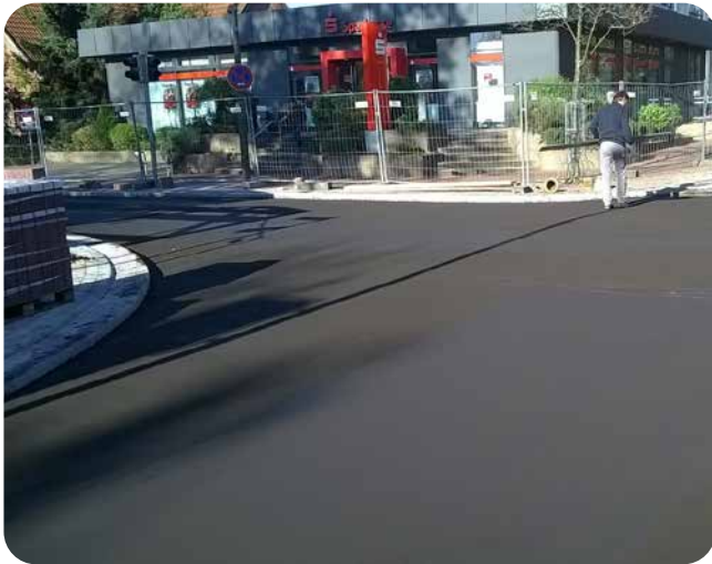
Die eingebaute ECOPREC®-Bettungsschicht ist für die Pflasterung vorbereitet
