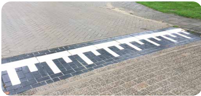
Rampe Tempo 30 mit Pflasterstruktur
