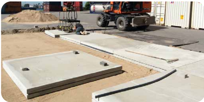
Verlegung MONODUR®-Connecton Platten
