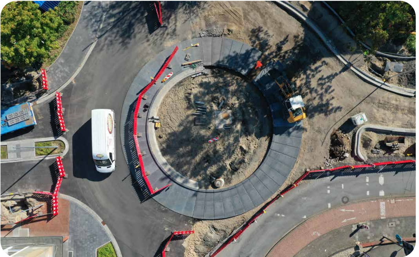
Versetzen eines MONODUR®-Kreisverkehrs mit halbseitiger Verkehrsführung
