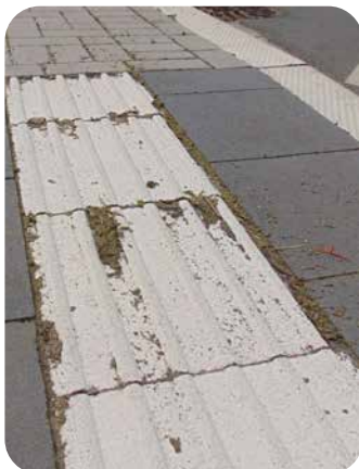
Verschmutzung durch abgesenkte Bodenindikatoren
