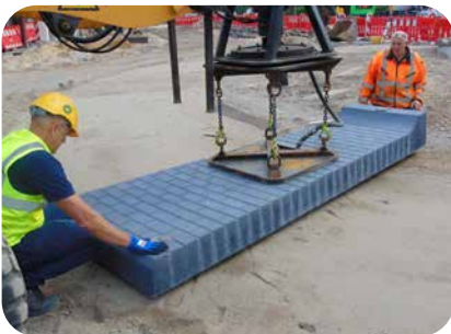
Schnelles Versetzen der vorgefertigten Segmente
