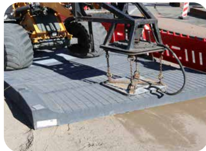
Versetzen eines MONODUR®-Kreisverkehrs mit halbseitiger Verkehrsführung
