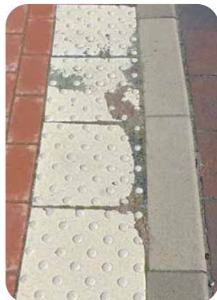
Verschmutzung durch abgesenkte Bodenindikatoren
