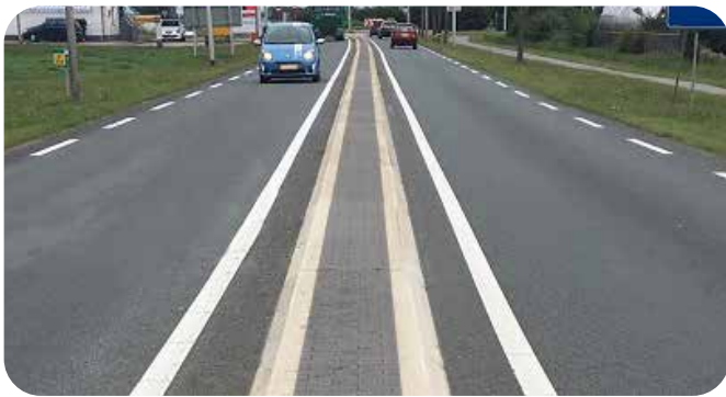
MONODUR®-Fahrbahnteiler aus Fertigteilen, vor dem Asphaltieren auf Schottertragschicht versetzt.
