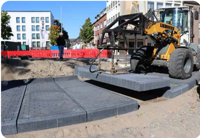
Verlegung der MONODUR®-Fertigteile
