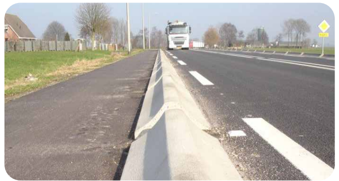
MONODUR®-Fahrbahnteiler aus Fertigteilen
