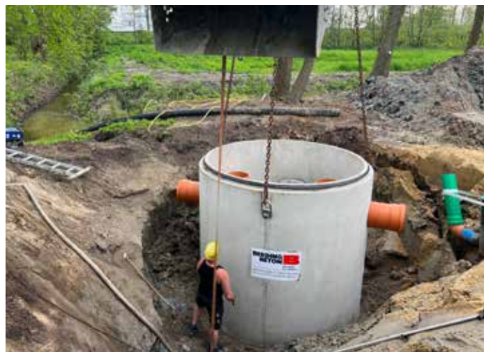
Montage des Schachtunterteils
