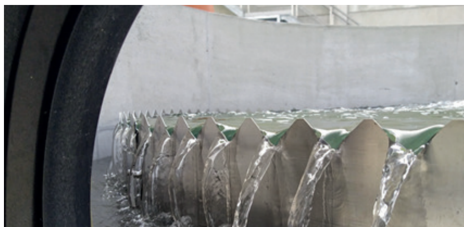
Vollflächiger Überlauf über das Zackenwehr
