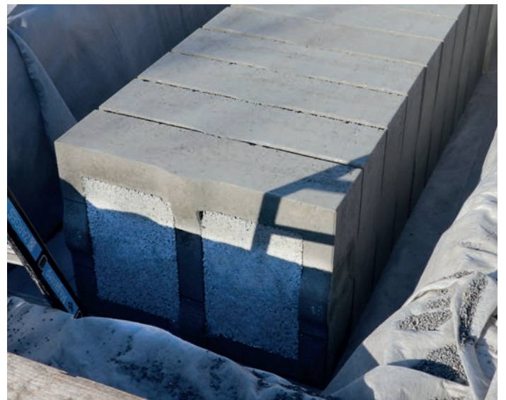
Das Endelement des beDrain®-Versickerungssystems.
