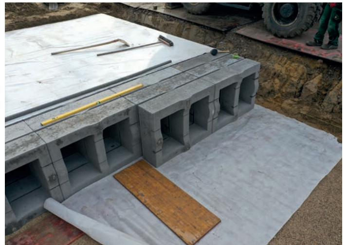
Versetzen der beDrain Elemente auf Vlies in der Baugrube.
