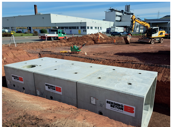
Betonrahmen 3,50 m x 2,0 m
