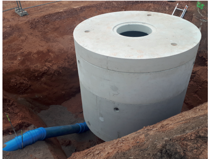
beDrop mit zusätzlichem Schachtring als Höhenausgleich und Wartungsöffnung DN 800
