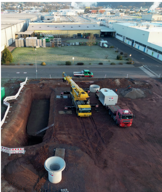
Anlieferung der Bauteile und Übersicht über die Baugrube
