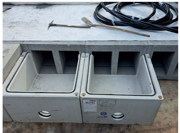
Einlauf- und Kontrollschacht je nach Bausituation in der Höhe anpassbar
