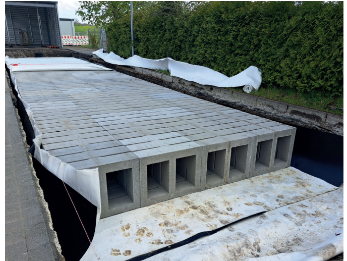
Kombination einzelner beDrain® Versickerungsblöcke zu großen Behältern
