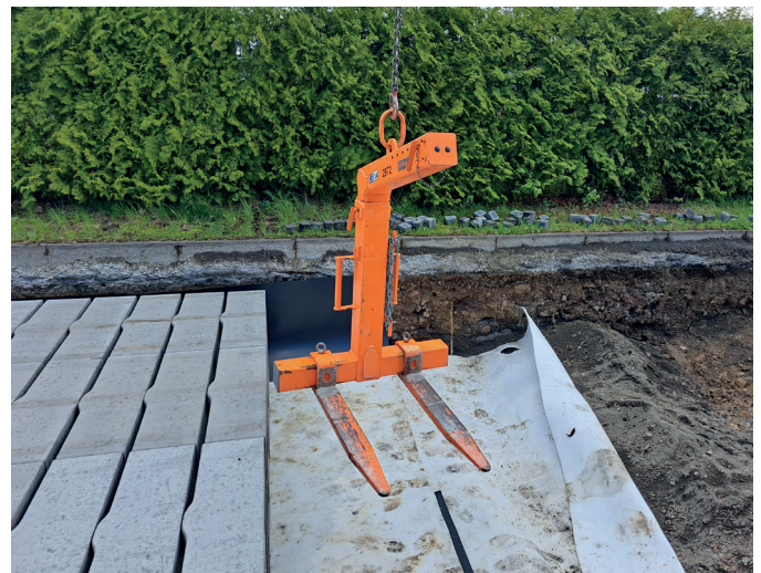
Einfache Montage mittels Palettengabel
