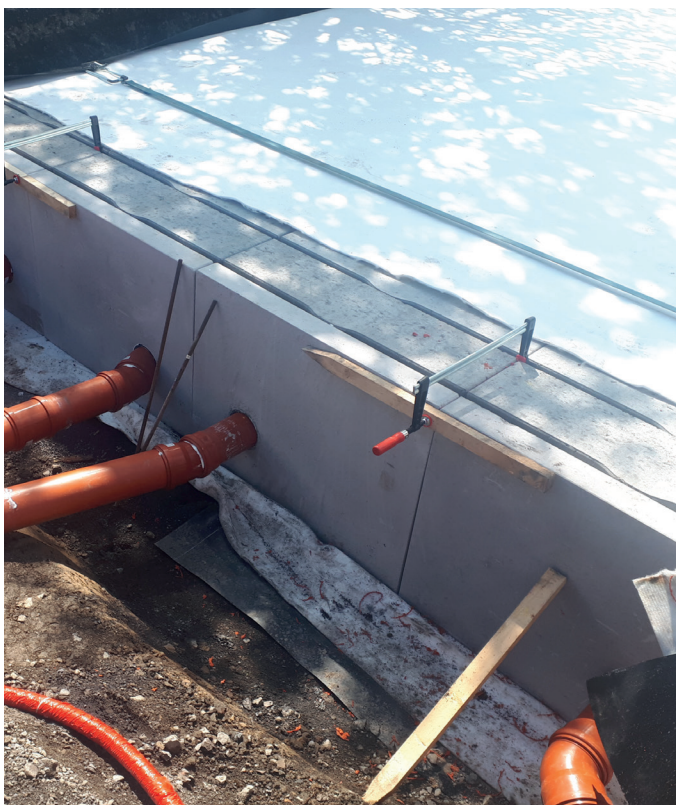
Verbauen der Anfangs- und Endplatten mit Schraubzwingen als Montagehilfe
