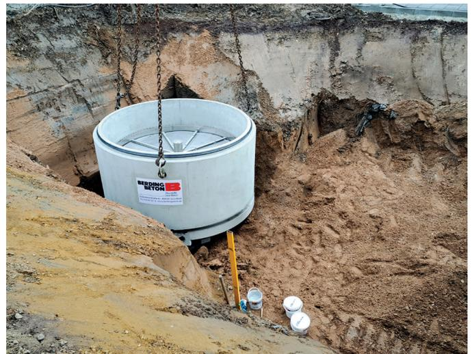
Montage des beClean® Schachtrings mit werkseitig vormontierter und befüllter Substratbox
