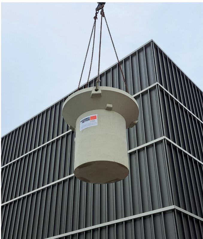
Das Versetzen des beClean® Schachtes mit Hilfe eines Autokrans
