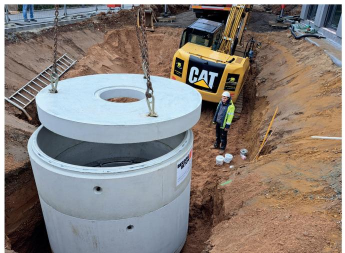
Montage der beClean® Abdeckplatte (für Verkehrslast LM1) mit Öffnung DN 800
