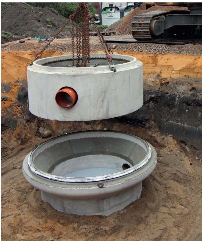
Montage des beClean® Schachtrings mit werkseitig vormontierter und befüllter Substratbox
