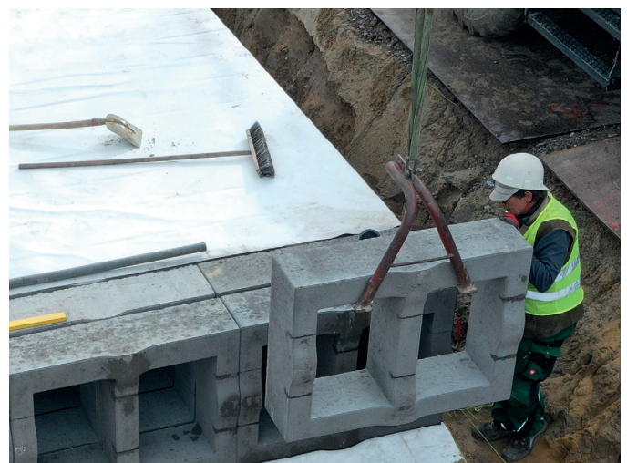
Einfache Montage mittel Versetzhilfe / Palettengabel
