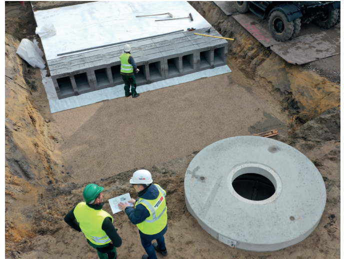
Abstimmung auf der Baustelle zwischen dem Bauunternehmer und BERDING BETON
