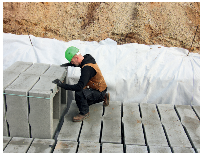
Kombination der Versickerungsblöcke zu einer großen Rigole
