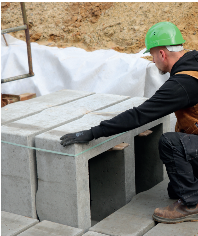
Einfaches Versetzen der Blöcke durch leichtes Führen der Palettengabel
