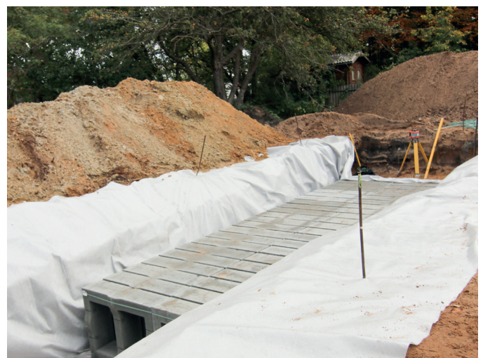
beDrain® Versickerungsblöcke mit Filtervlies Secutex 151 GRK 3 C, 150g/m 2 ummantelt
