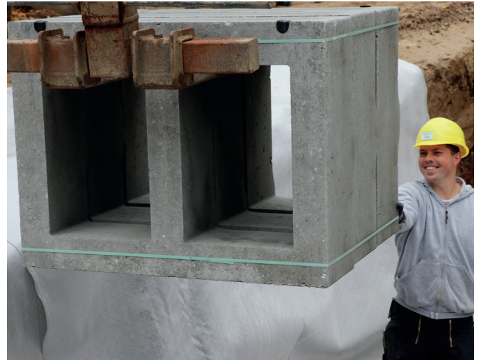
Gebündelte Montage von drei Blöcken mittels Palettengabel
