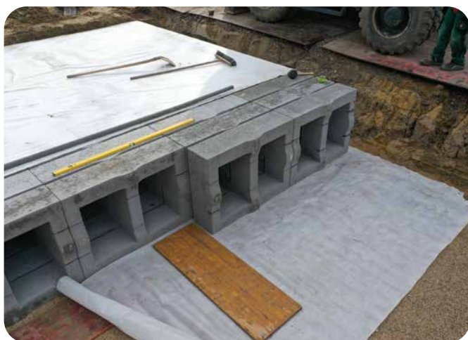
Versetzen der beDrain ® Elemente auf Vlies in der Baugrube
