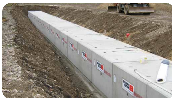
Stauraumkanäle als rechteckige und kreisrunde Stahlbetonrohre (Verteilerbauwerk für den Anschluss großformatiger Betonrohre)
