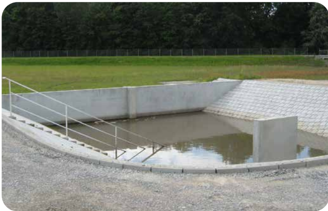
Becken mit systemintegrierter Treppe und Überlauf
