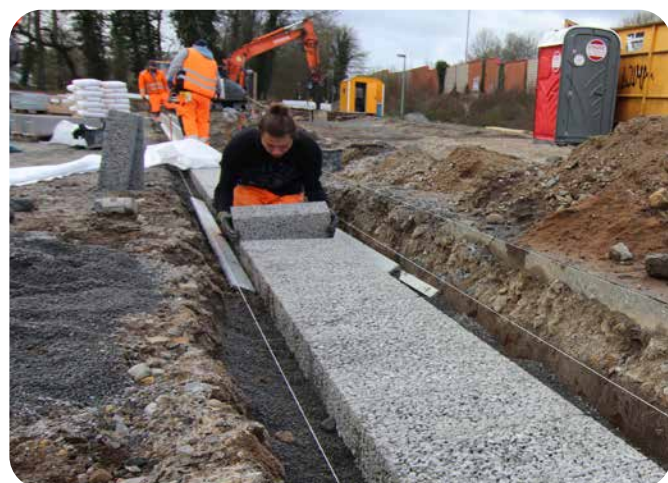
Verlegen des Drainbetonsteins auf Splittbettung
