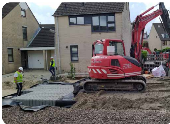
Verlegung direkt über bereits gesetzte Blöcke
