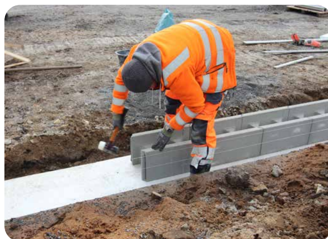
Setzen des Rigolenelements
