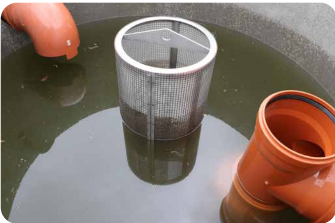
Der bePlus scheidet Sedimente mit seinen von allen Seiten angeströmten runden Filterflächen sicher ab
