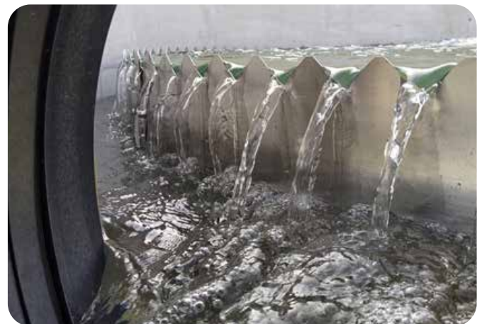
Vollflächiger Überlauf über das Zackenwehr
