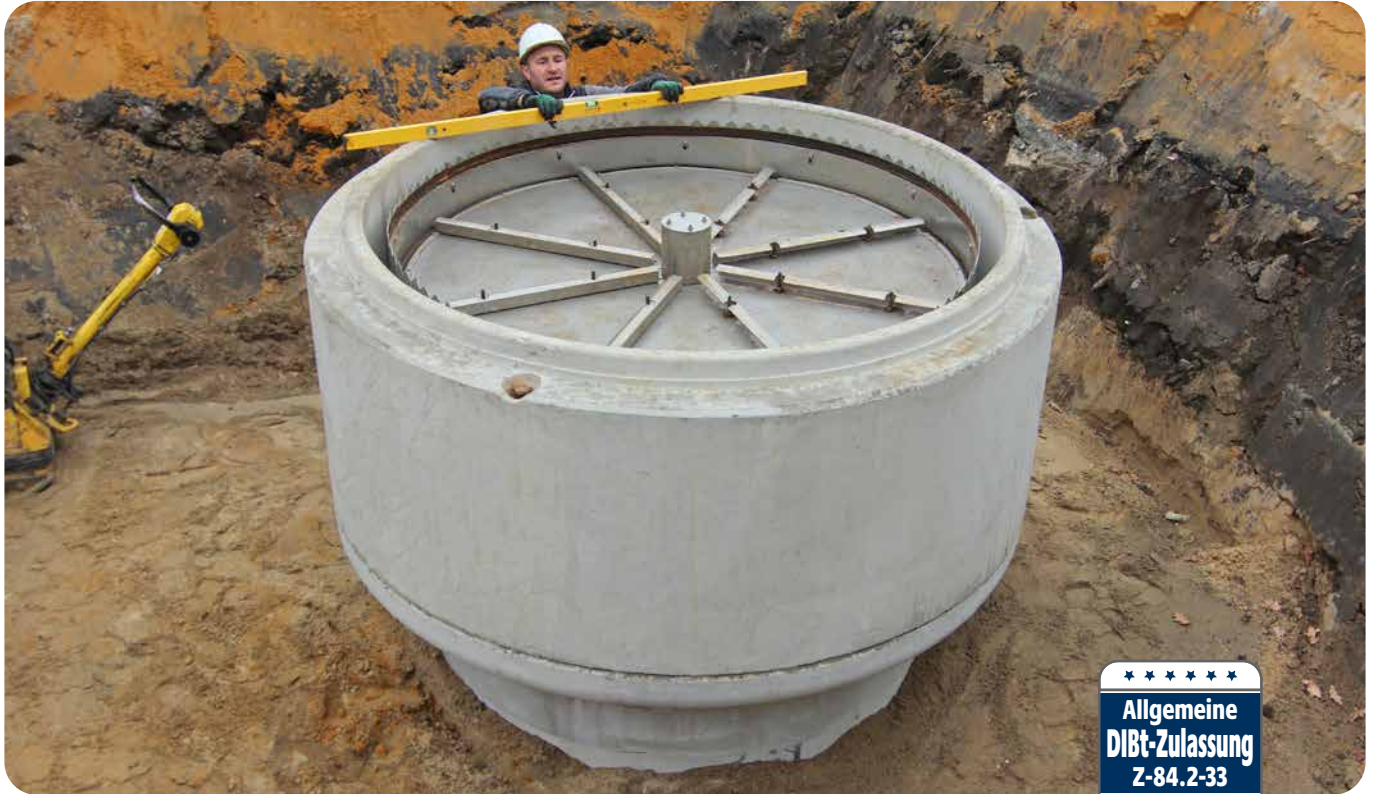
Einbau einer beClean® -Niederschlagswasser-Behandlungsanlage
