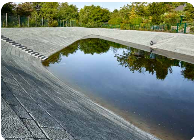
Becken aus wasserdurchlässigem Verkalit®-Aqua
