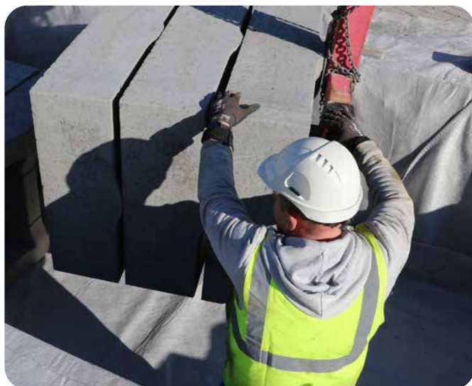
Mittels Palettengabel lassen sich drei Teile gleichzeitig setzen
