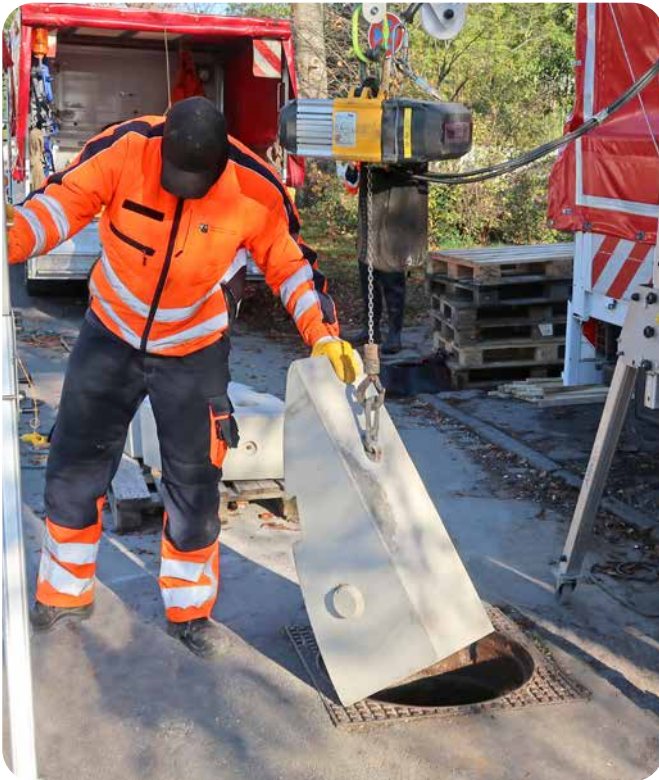
Ablassen eines abgerundeten Kanalsohlsteins, der in jedem normalen Schacht verbaut werden kann.
