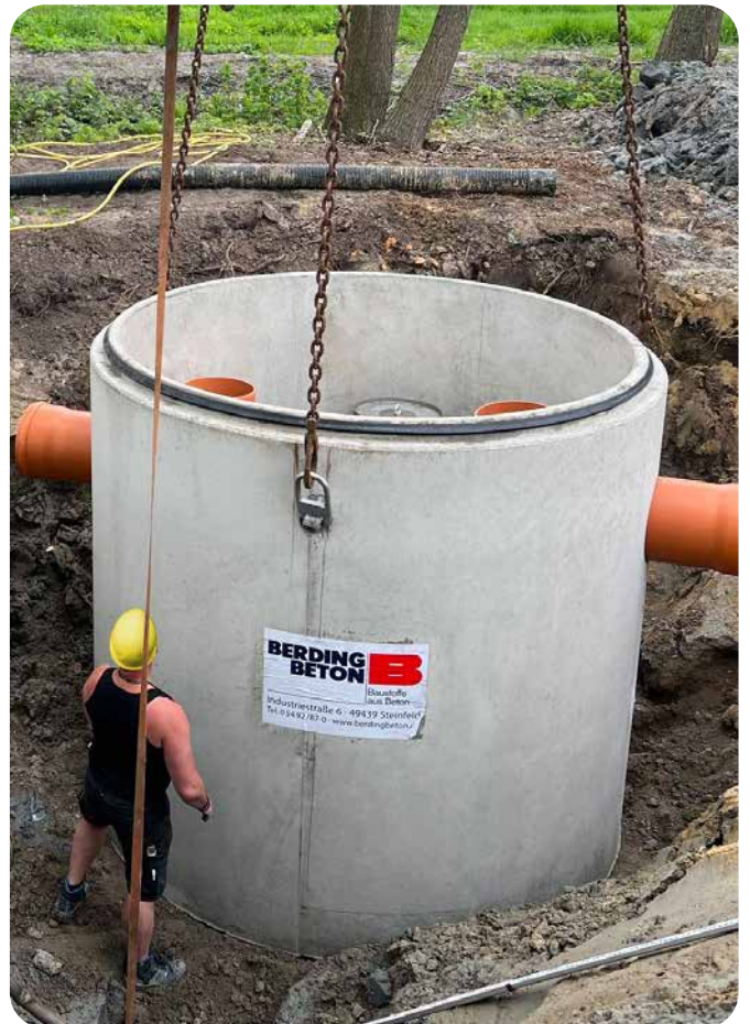
Der bePlus scheidet Sedimente mit seinen von allen Seiten angeströmten runden Filterflächen sicher ab
