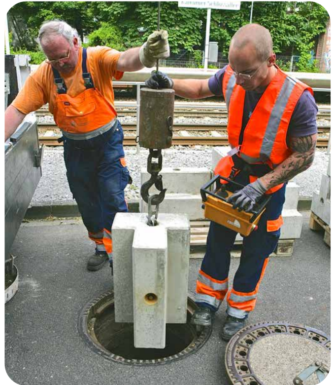
Ablassen eines T-förmigen Kanalsohlsteins, der in jedem normalen Schacht verbaut werden kann.
