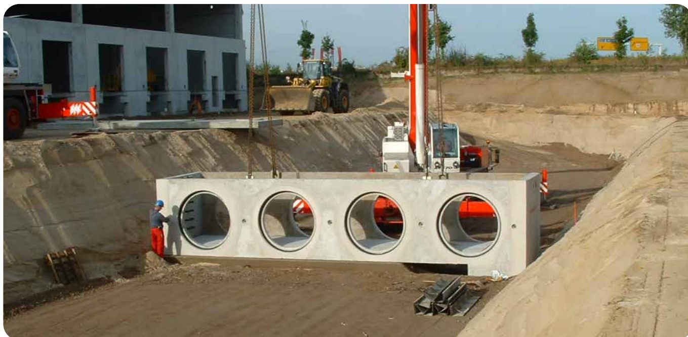
Stauraumkanäle als rechteckige und kreisrunde Stahlbetonrohre (Verteilerbauwerk für den Anschluss großformatiger Betonrohre)
