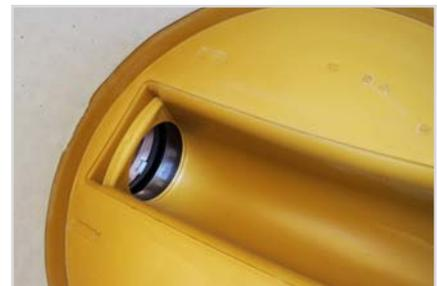
SW-Hausanschluss DN 600 mit gelbem Kunststoff-Inliner
